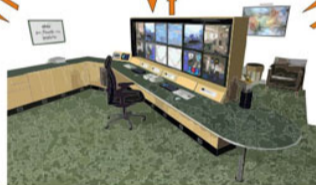
Pult centralizované ochrany - PCO
